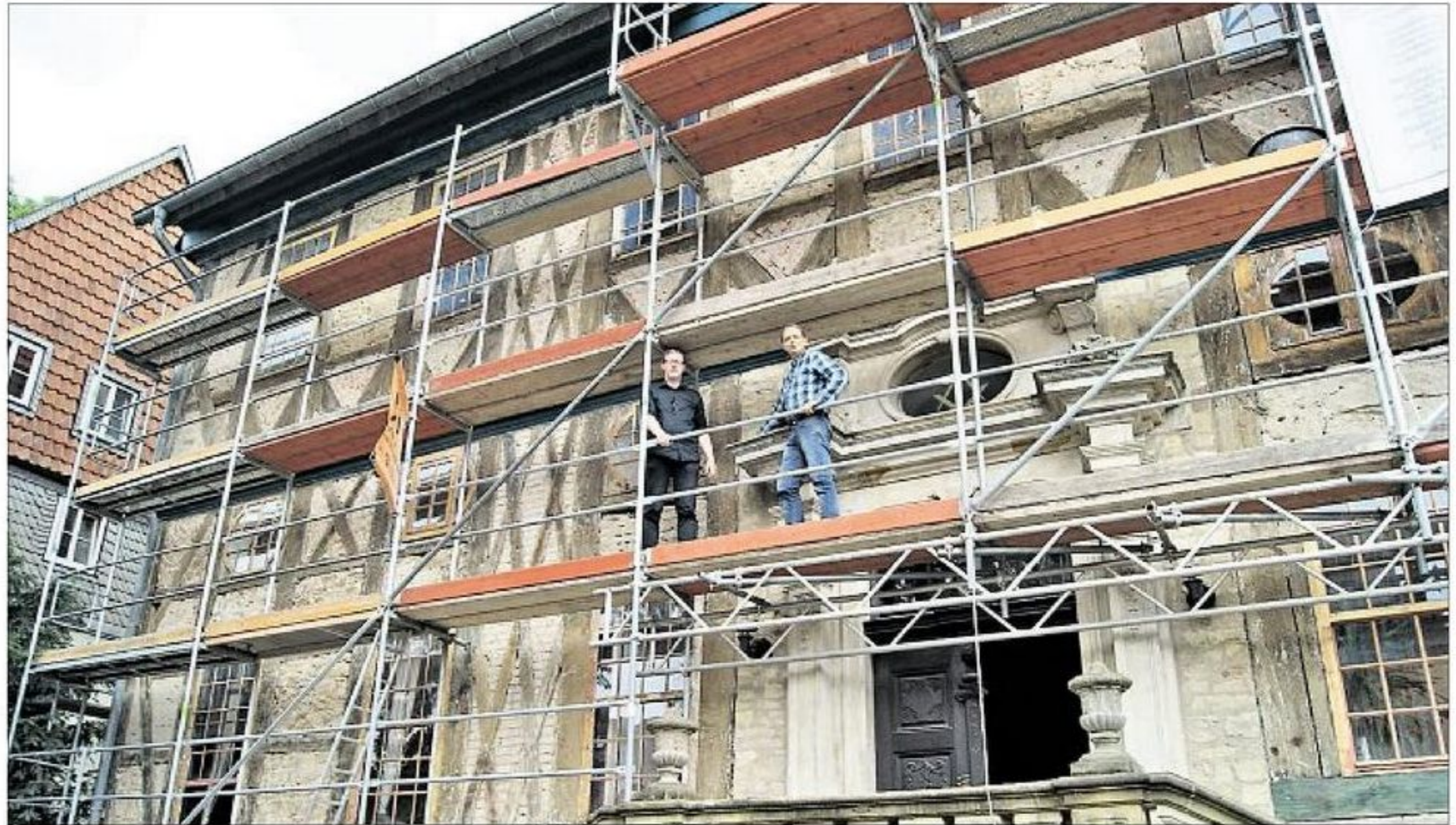
Denkmalpfleger Stefan Beate und Architekt Wilfried Feise schauen bei der freigelegten Fassade des Logenhauses genau hin.
